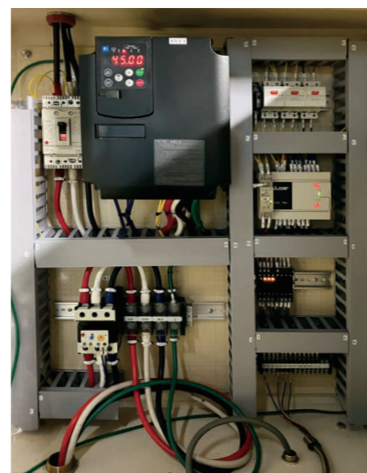
インバータ式動力盤(新)
